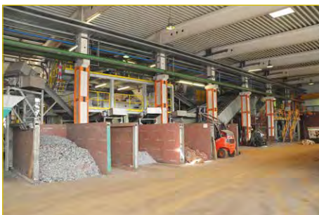
Bild 12: Anlage der Adamec Recycling GmbH zum hochwertigen Recycling
