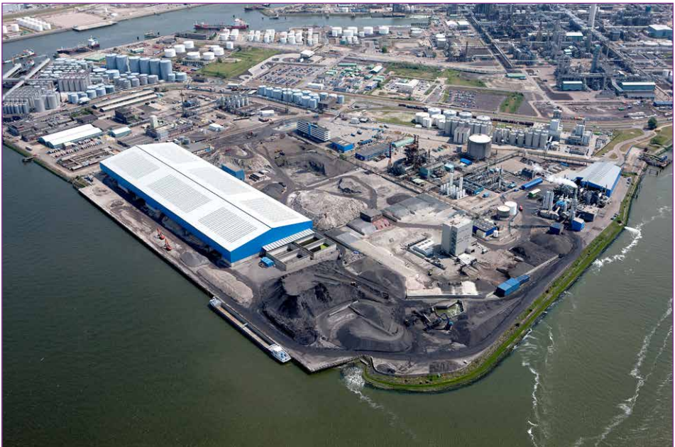
Bild 1: Recycling-Anlage in Rotterdam
