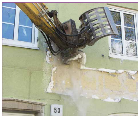
Bild 7: WDVS-Rückbau mit Bagger
