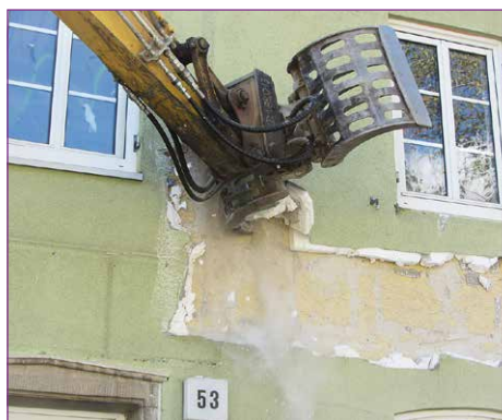
Bild 7: WDVS-Rückbau mit Bagger
