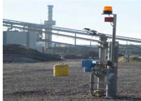
Bild 8: Berieselungskanonen zur Benetzung mit Niederschlags- oder Frischwasser
