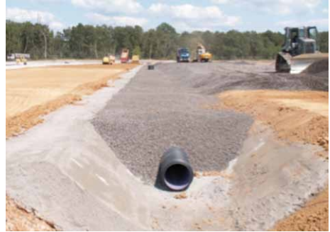
Bild 6: Bau der Basisabdichtung mit Gießpfannenschlacke und Nutzung von LD-Schlacke als Drainagematerial
