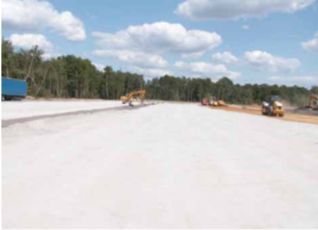
Bild 6: Bau der Basisabdichtung mit Gießpfannenschlacke und Nutzung von LD-Schlacke als Drainagematerial
