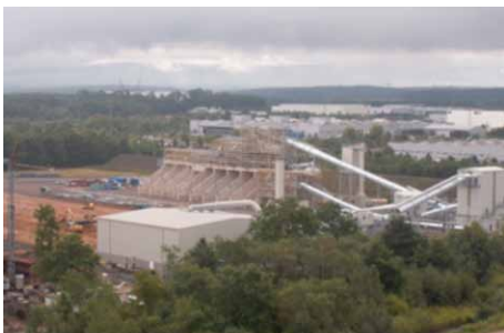
Bild 10: Teilansicht der Mineralstoffaufbereitungsanlage MSG mit Aufgabehalle, Magnetturm, Bunkersystem und teilweise bereits eingehauster Hauptsiebhalle während der Bauphase
