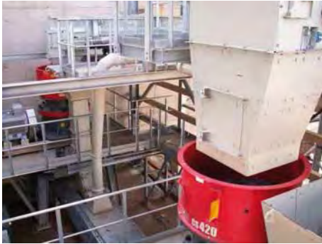
Bild 4: Blick auf den Steilkegelbrecher und Flachkegelbrecher während der Bauphase
