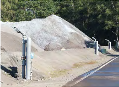
Bild 8: Berieselungskanonen zur Benetzung mit Niederschlags- oder Frischwasser
