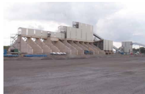
Bild 10: Teilansicht der Mineralstoffaufbereitungsanlage MSG mit Aufgabehalle, Magnetturm, Bunkersystem und teilweise bereits eingehauster Hauptsiebhalle während der Bauphase
