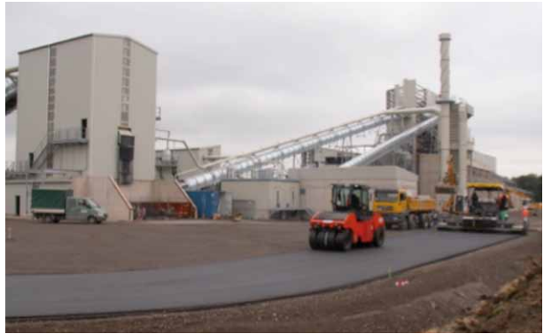
Bild 7: Nutzung eigener mineralischer Produkte beim Bau der Außenanlage
