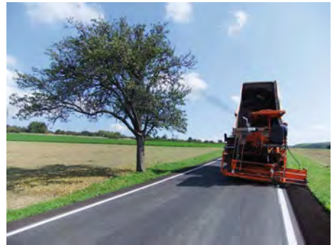
Bild 13: Einsatz von SCODILL im Waldwegebau im Dillinger Hüttenwald und für die Herstellung von Straßenbanketten
