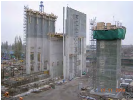
Bild 8: Gleitbau 1
