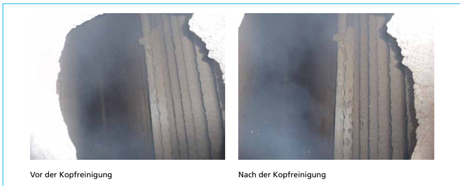
Bild 3: Reinigungseffekt an einem Proberohr mit Nebenform im Überhitzerbereich der MVA Rosenheim
