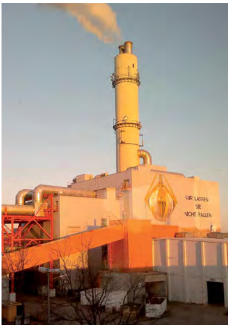
Bild 1: Abgasnachreinigung und Kamin der MVA Stelling Moor
