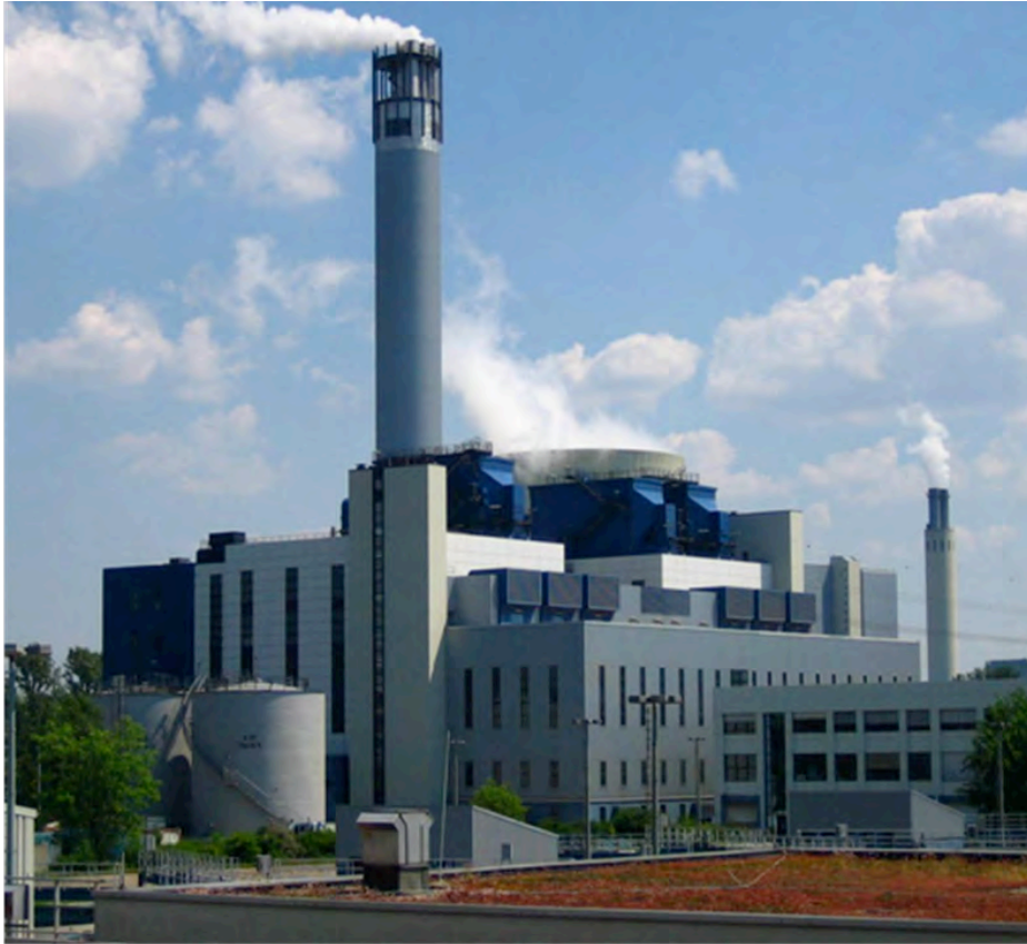
Bild 2: Schlammverbrennungsanlage im Klärwerk Ruhleben
