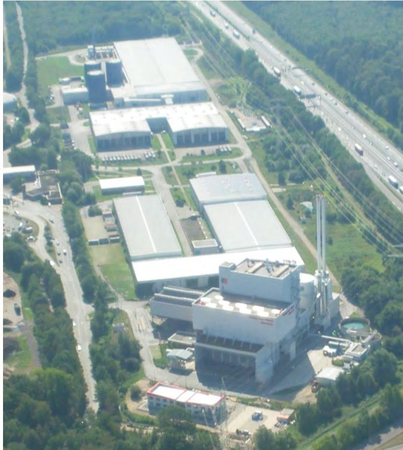
Abb. 2 Standort Hannover: MVA (im Vordergrund), Bioabfallkompostwerk (Mitte) und MBA; rechts oben: Autobahn A2
