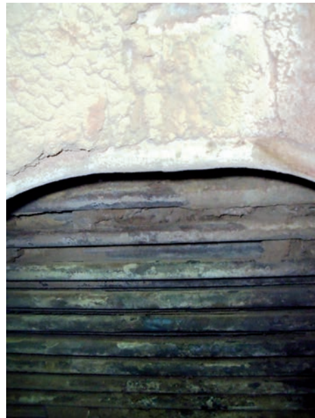
Bild 2: Kesseleinbauten nach der Sprengreinigung
