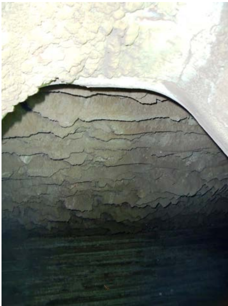
Bild 1: Kesseleinbauten vor der Sprengreinigung
